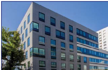
Immeuble de bureaux de 11 000 m² à NANTERRE (92) Livré le 22 janvier 2014
