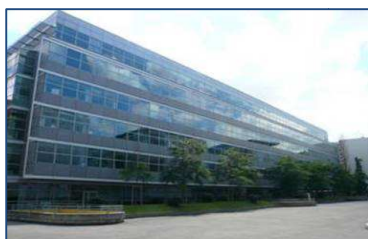
Pantin - Rue Courtois Bureaux 7 977 m 2 Acquis en 2007
