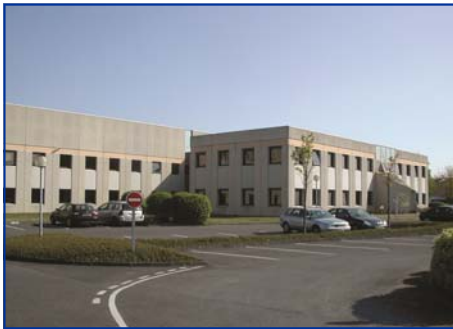
Boulevard de Beaubourg, Croissy-Beaubourg (77) Acquis le 27 avril 2007
