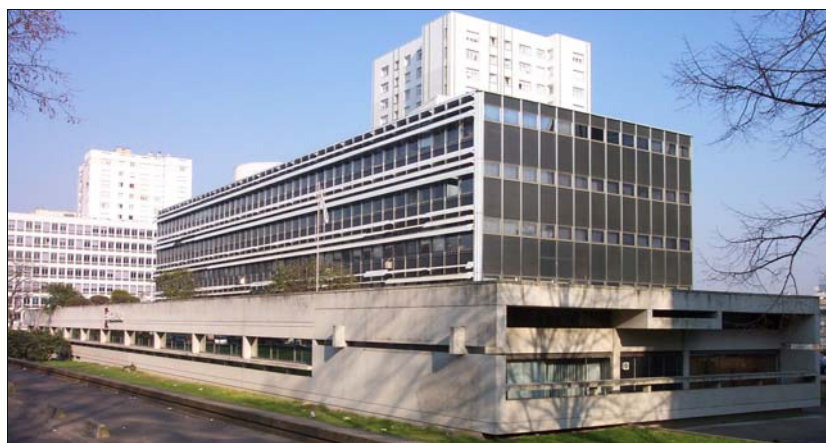
Immeuble de 8000 m 2 loué à la société SOLETANCHE 6 rue de Watford, 92000 NANTERRE
