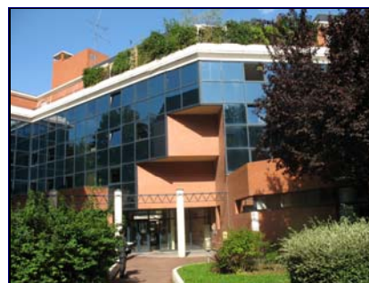
Immeuble Bir Hakeim, Saint Maurice (94) Acquis le 20 mars 2007
