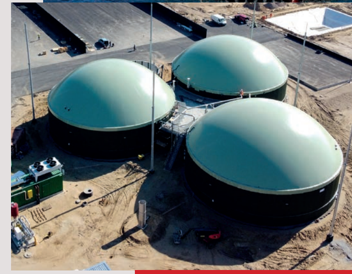
Usine de biogaz ■ Pologne
