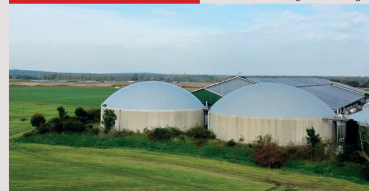
Usine de biogaz ■ Allemagne
