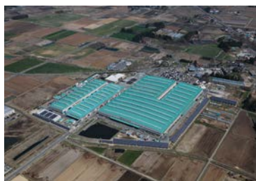
Tohoku Factory mega solar
